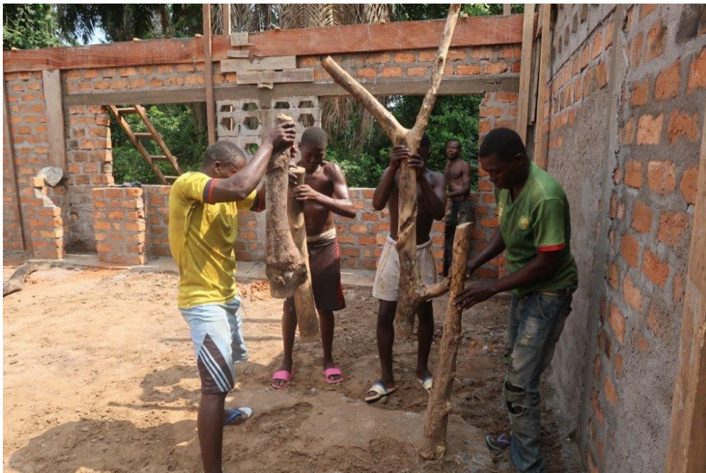
Testant la nouvelle technologie de compactage du sol dans le nouveau bureau de PAPA © Luis Arranz
