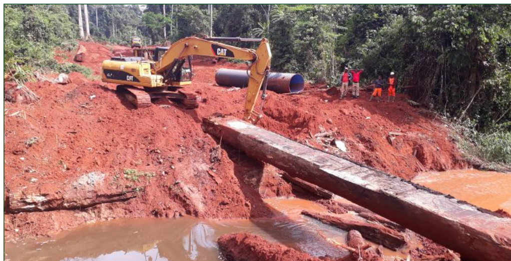
Démantèlement d'un pont après exploitation (© CIFM-Pallisco).
