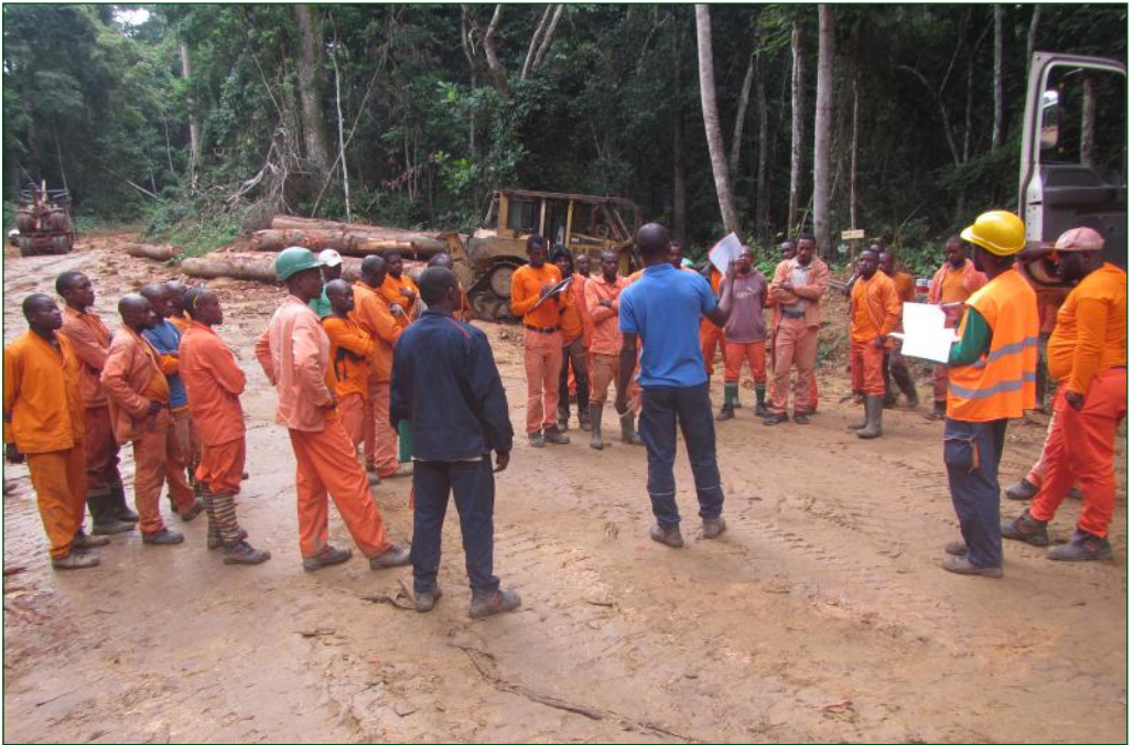
Réunion de sensibilisation des travailleurs sur le chantier (© P. Jeanmart).
